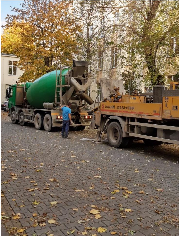
Betonowanie w ramach Grantu Rektora-KNBiG
